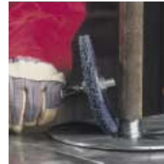
Čišćenje zavarenog spoja Stranica 04
